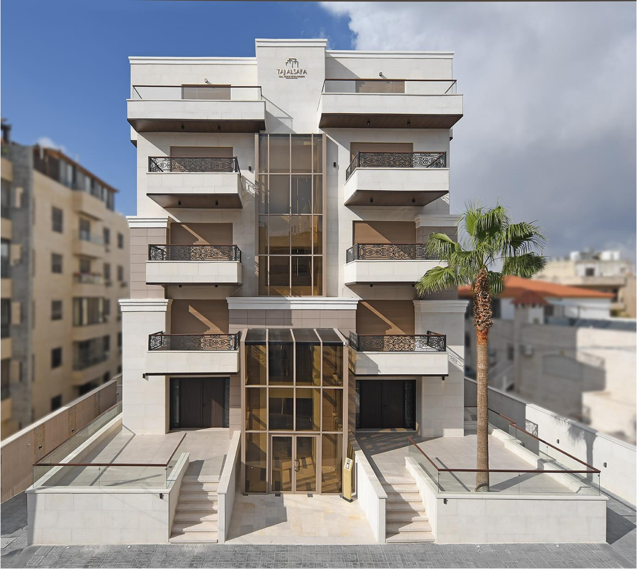
AL SWIEFIEH PROJECT
